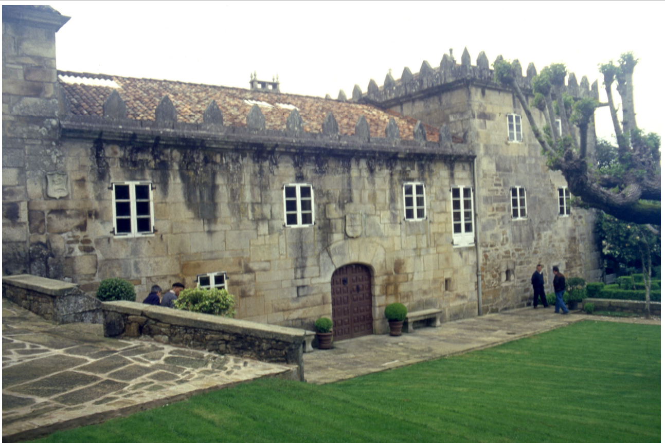
Fachada principal das Torres de Romelle [foto XMLS, 2001]
